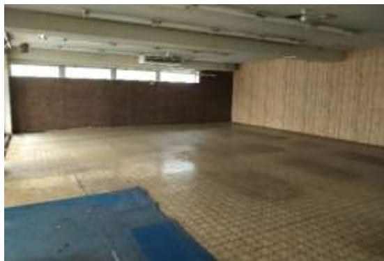
什器片付け作業後の様子
