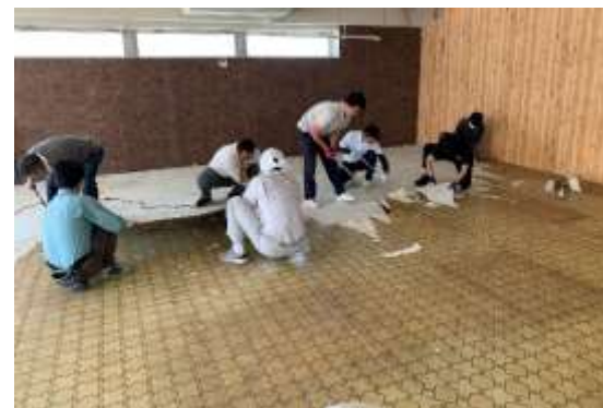
床材剥離作業の様子
