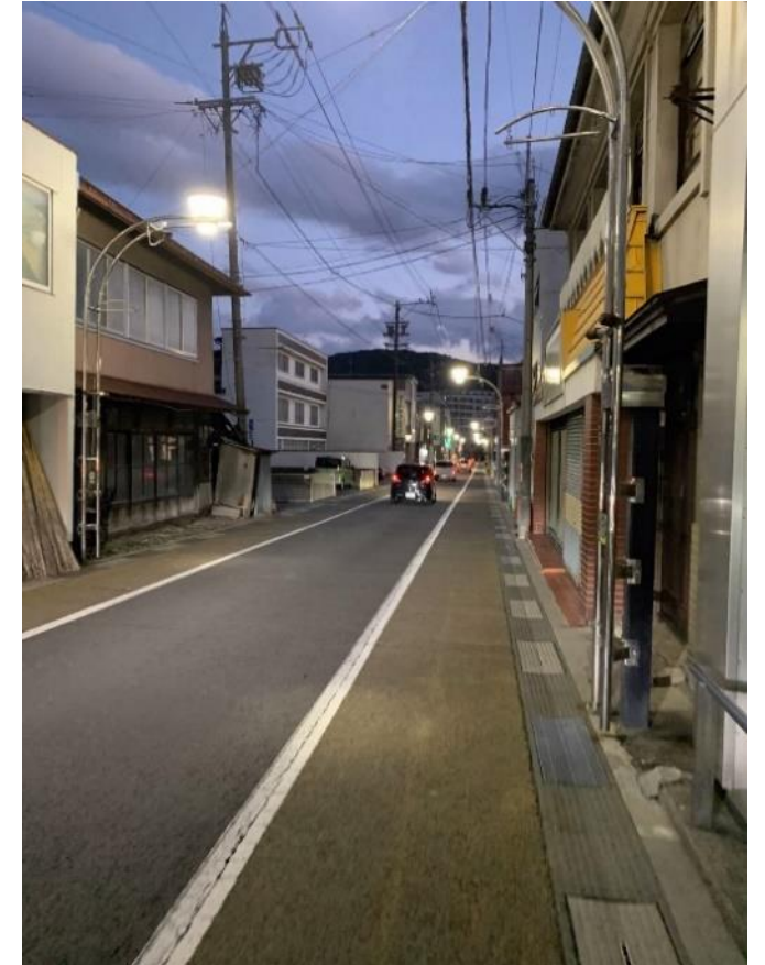
【LED化後の街路灯】
